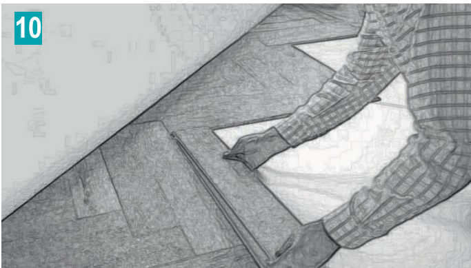
10 VERLEGUNG DER FLÄCHE
